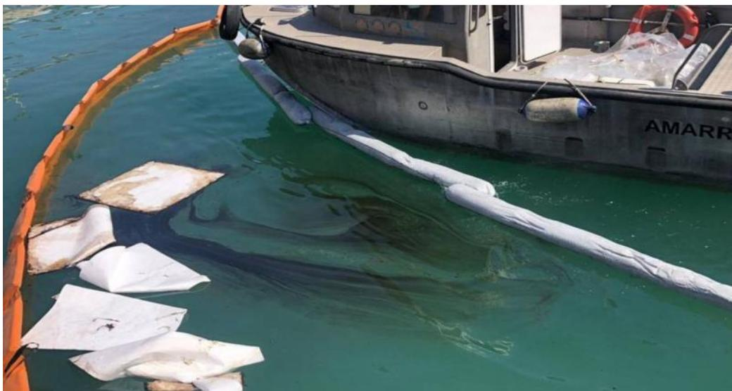
MANTA ABSORBENTE, 100% polipropileno. Ideal para recoger vertidos de aceites y otros hidrocarburos—aceite derramados, de forma rápida y eficaz. Reutilizable
